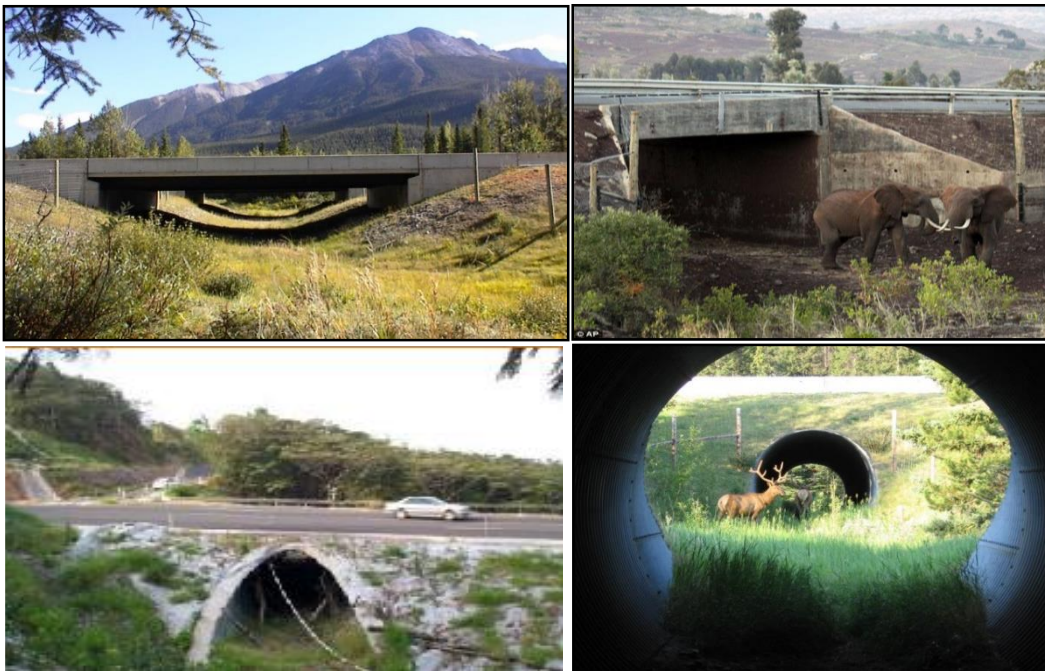
රූපසටහන 5.2: සත්ත්ව සංවරණය සඳහා නිර්මාණය කරන ලද යටිමං පාලම් හා බෝක්කු
